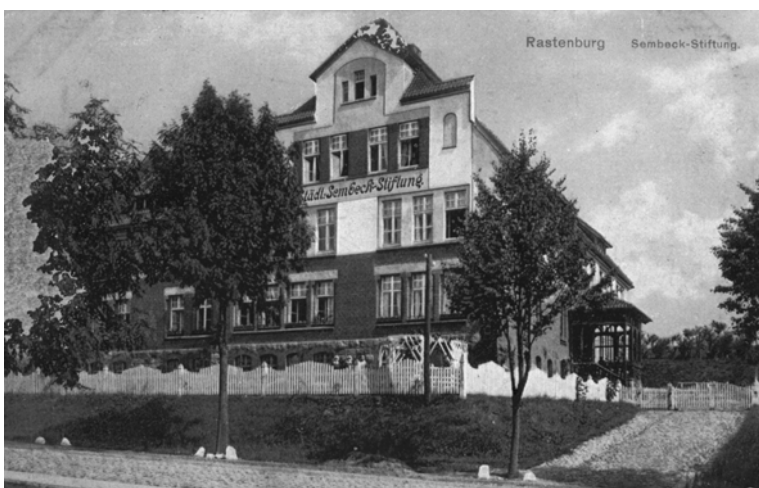
145. Budynek fundacji E. Sembecka, 1903r. (ob. siedziba sądu przy ul. Sikorskiego)
