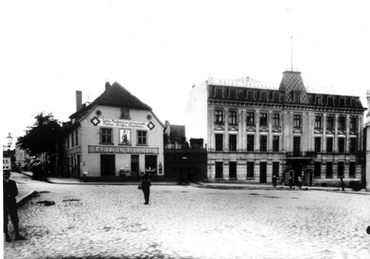
212. Hotel „Thuleweit” przy Nowym Ryнку, 1905r.
