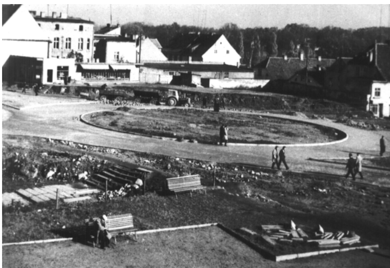
217. Budowa ronda im. Jana Pawła II, 1965r.
