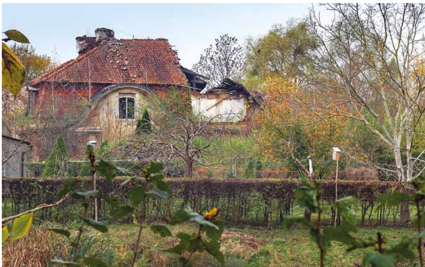
Pałac, stan obecny
