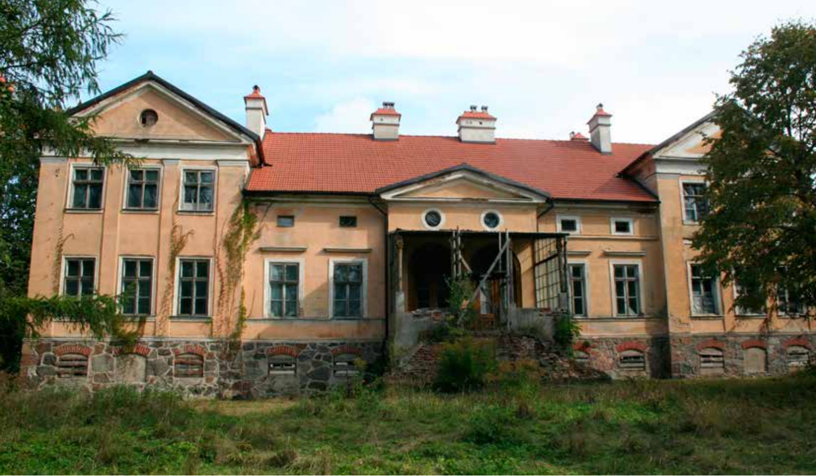
Elewacja ogrodowa, stan obecny
