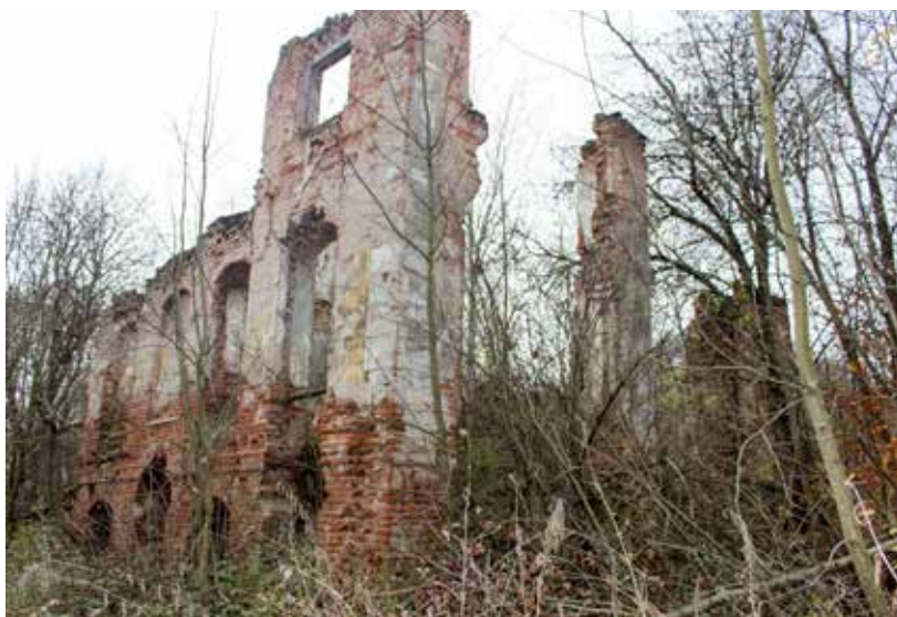
Elewacja ogrodowa, stan obecny
