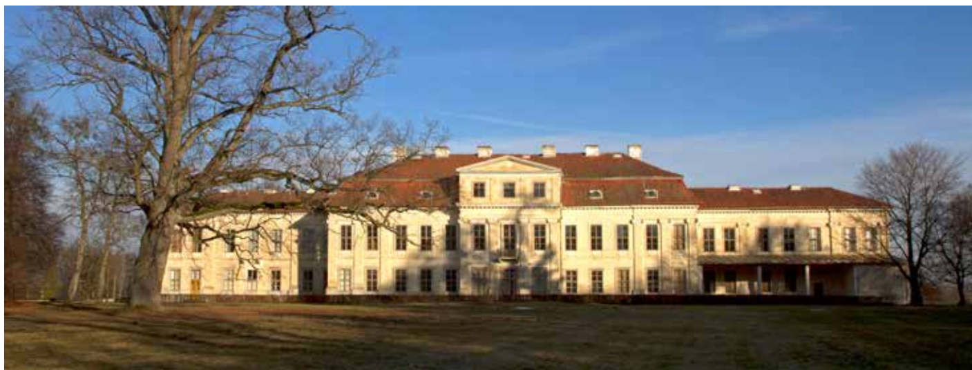
Elewacja ogrodowa, stan obecny
