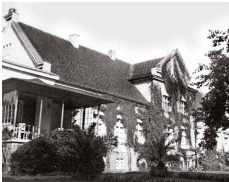
Elewacja ogrodowa, stan sprzed 1945r.
