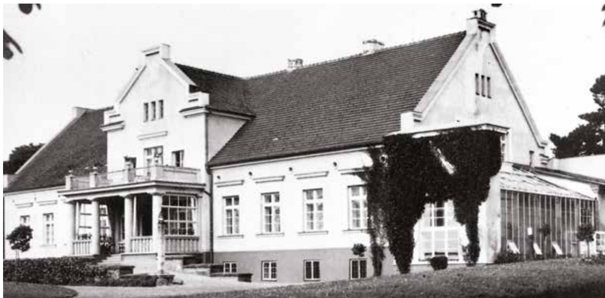
Elewacja frontowa, stan sprzed 1945r.
