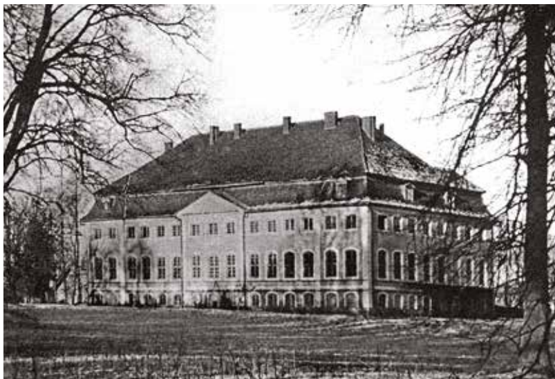
Elewacja ogrodowa, stan sprzed 1945r.
