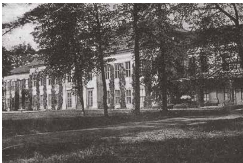
Elewacja ogrodowa, stan sprzed 1945r.
