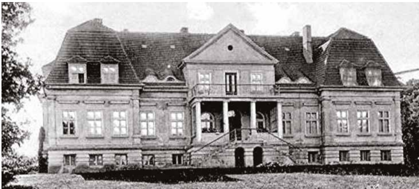
Elewacja ogrodowa, stan sprzed 1945r.
