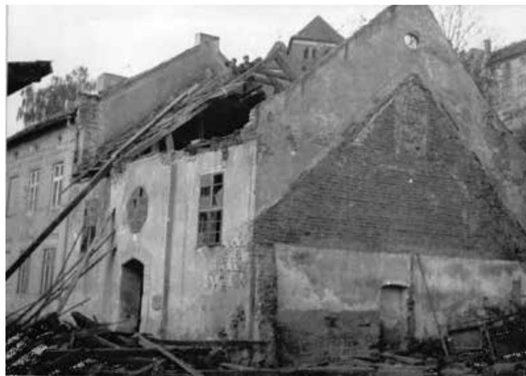
Kaplica w trakcie rozbiórki w 1959r.
