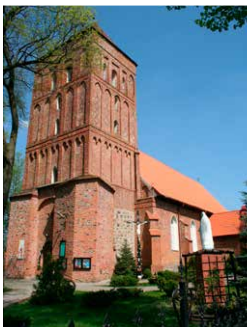
Wieża i fragment elewacji południowej
