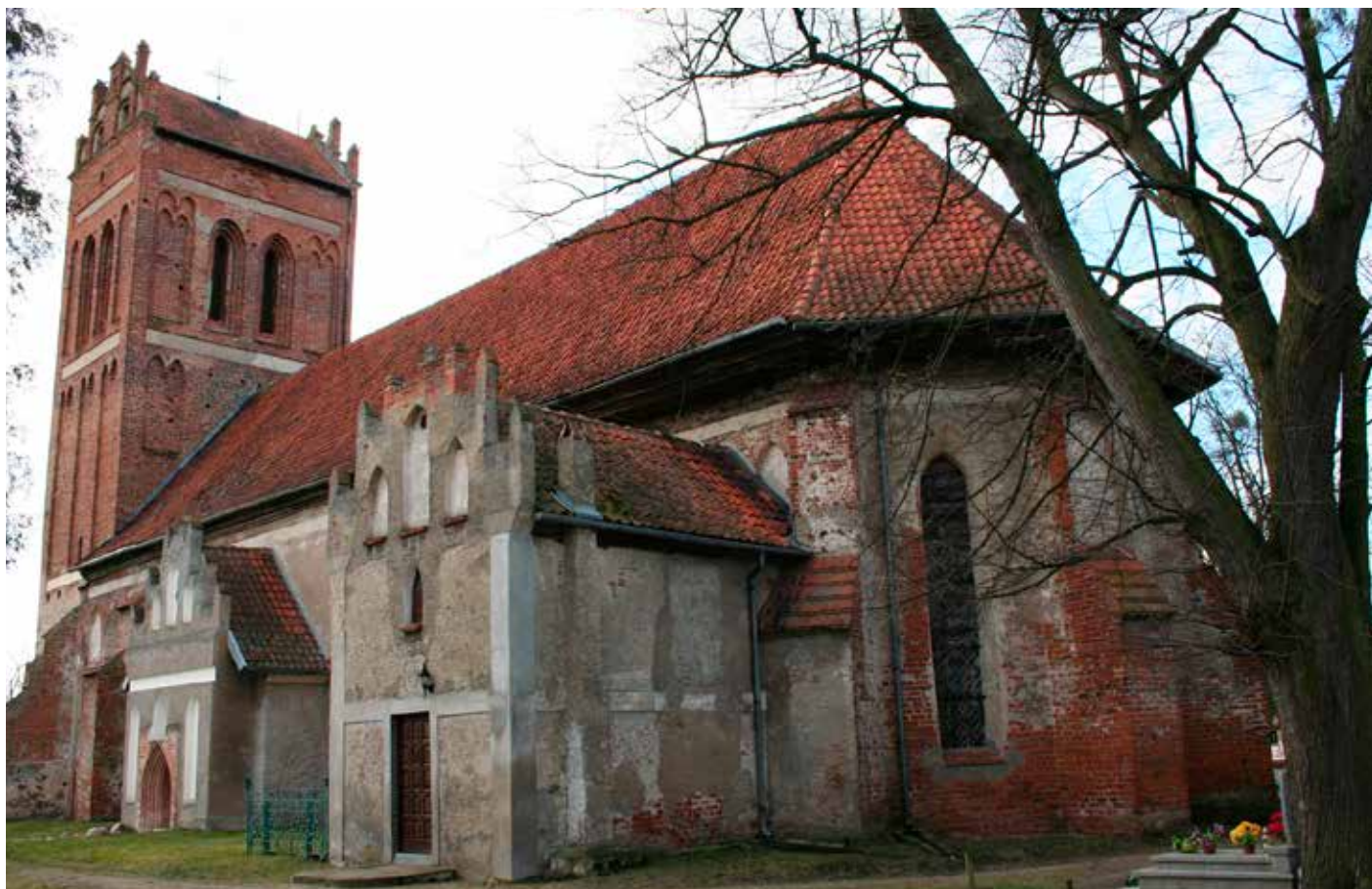
Elewacja południowa z dostawioną kaplicą grobową rodu zu Eulenburg, w głębi kruchta
