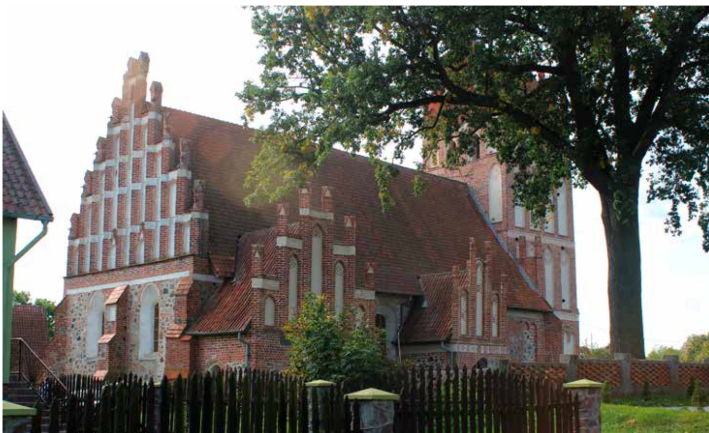
Elewacja wschodnia i północna z zakrystią i kruchtą
