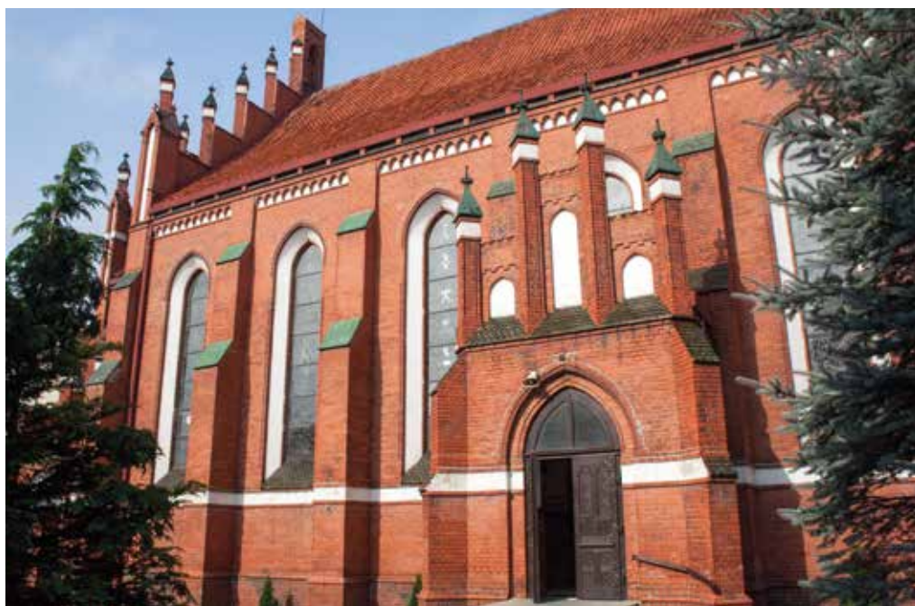
Elewacja boczna z wejściem
