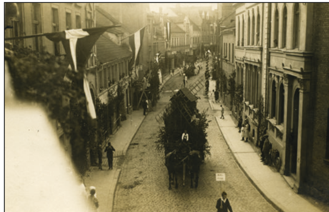
196) 1929 - ul. Traugutta / Angerburger Straße
