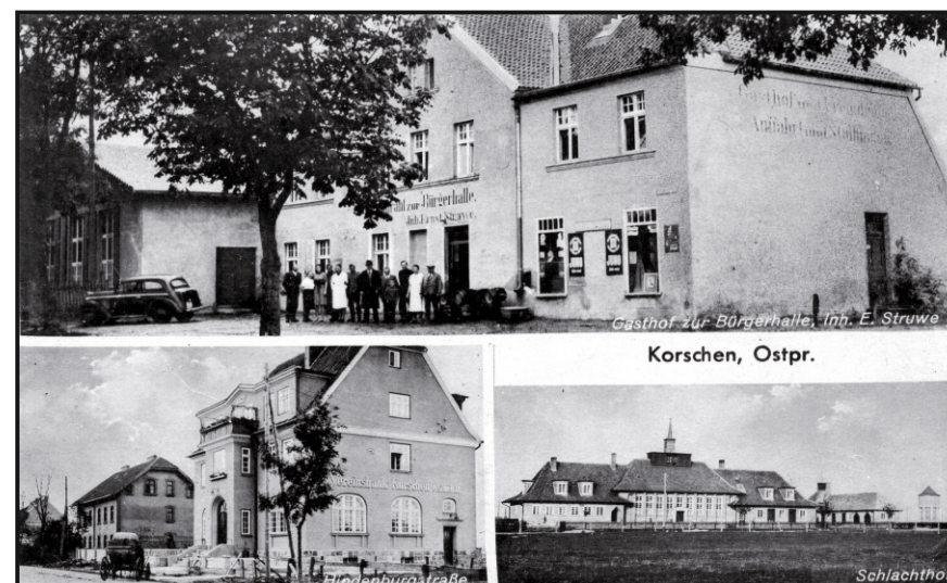
Oberża ze świetlicą, bank, rzeźnia (1942r.)
